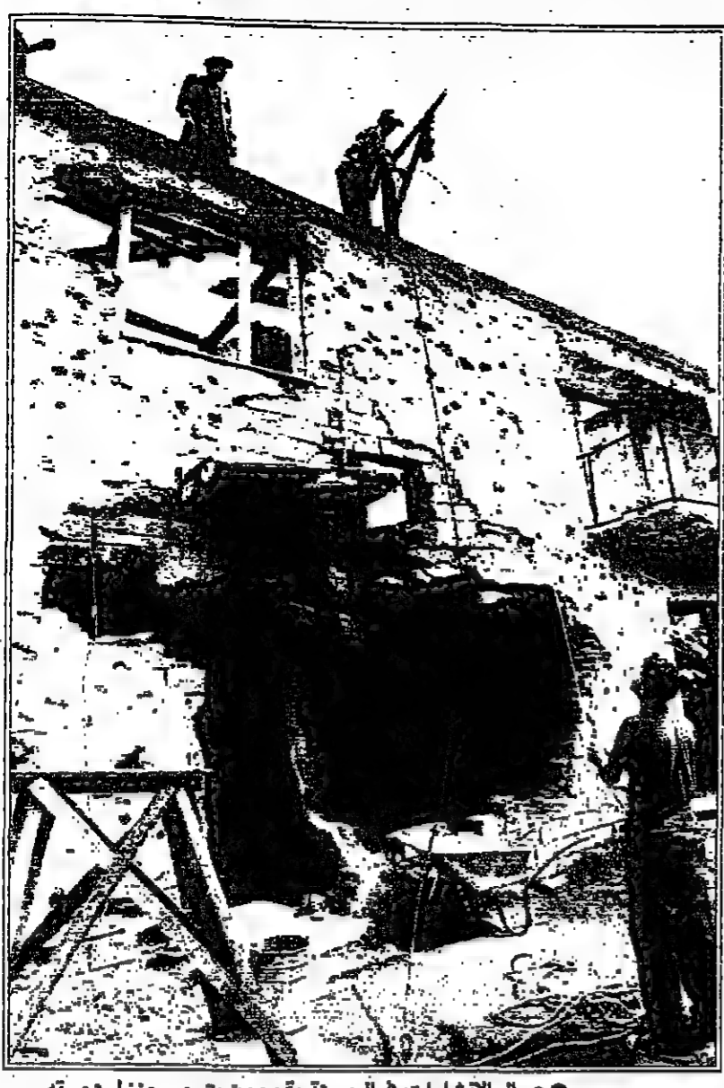
عمال الانشاءات في البوسنة يقومون بترميم منزل دمرته الحرب في احد ضواحي سراييفو. (رويتز)
